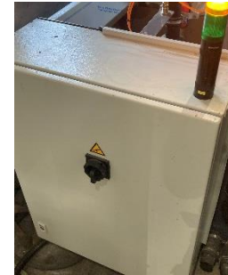
Hauptschalter Filteranlage
